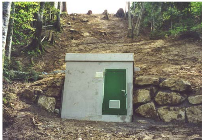
Quellfassung- und Leitungssanierung Kreuz, Koster Ingenbohl
